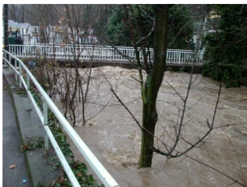
Ouvrage limitant et en charge (pont du stade du Merlo) en décembre 2003
