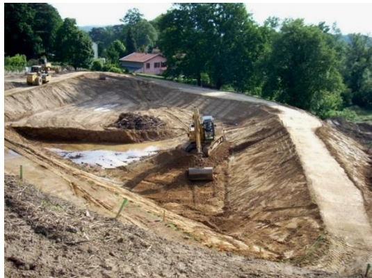
Construction du bassin de rétention des Sables à Chaponost (2008)
