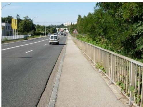
RD342 à Ste Foy-lès-Lyon, avant la crue
