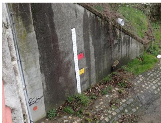
Figure 21 : Echelle limnimétrique en place avec les niveaux de vigilance et d'alerte
