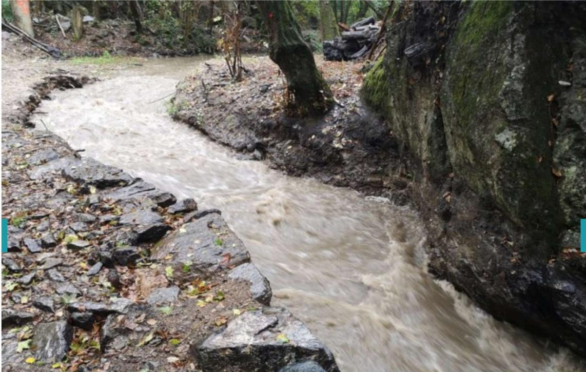
L'entrée amont de la rivière de contournement s'est faite à une altimétrie inférieure afin de permettre au sable d'être chassé et regagner un substrat plus grossier et favorable aux poissons. L'idée était également de supprimer l'effet « plan d'eau » induit par le seuil.
