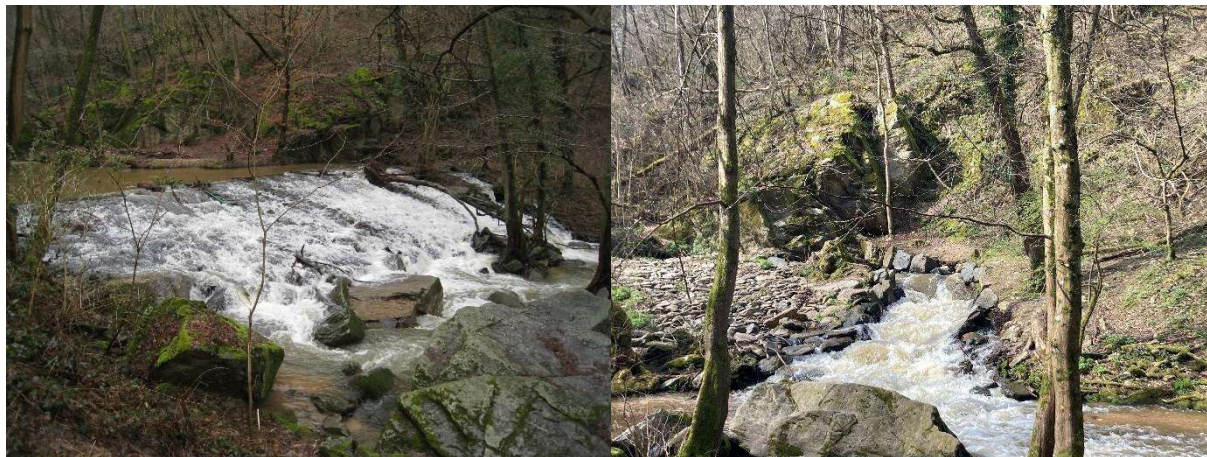
Photos du seuil de la Roussille, haut de 3 m, avant et après les travaux d'aménagement de la rivière de contournement par le Sagyrc en 2020.
